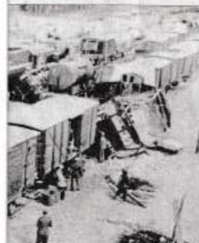
Güterwagen. Ein Ölwagon hatte Feuer gefangen und die große Rauchwolke verursacht. Das gesamte Bahngelände war ein Trümmerfeld. Auch die Häuser des Bahnhofsviertels hatten Schäden davongetragen, ihre Statik hielt aber.
