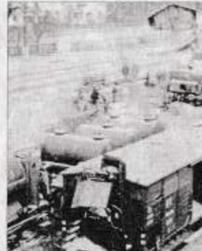
Zahlreiche abgestellte Waggons wurden beim Luftangriff auf den Bahnhof beschädigt und zerstört sowie von ihrem Sockel gerissen.
