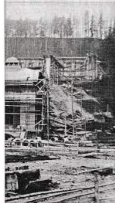
Die Kraftwerksbaustelle von oben gesehen, in der Perspektive der Fallrohre in Richtung Süden.
