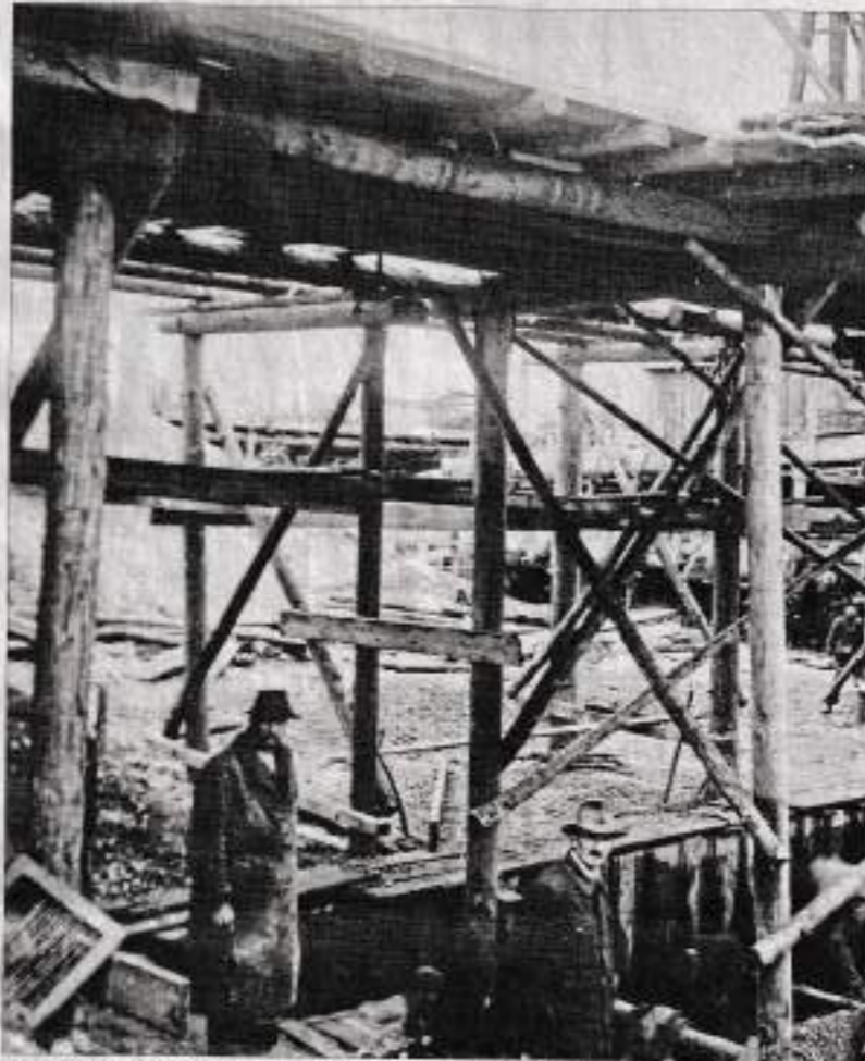
Die Baustelle des Caro-Kraftwerks bei Hirten mit einer Spundwand, Geländesprünge, der zugleich eine Dichtungsfunktion übernehmen kann gegen Wasser gebaut. Holz war vor einem Jahrhundert ein weit wichtiger
